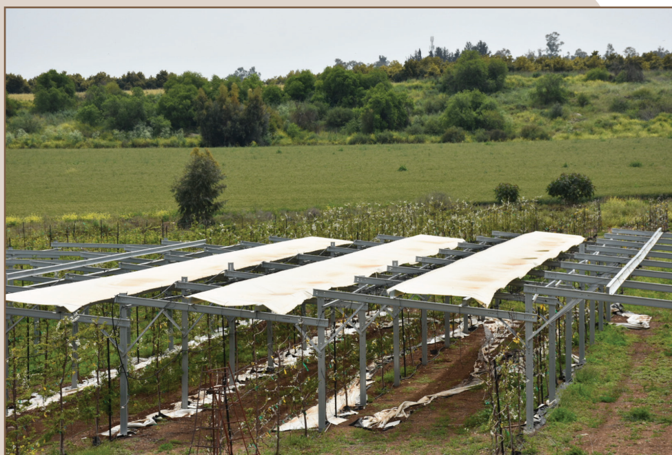
نمونه سامانه اگروولتائیک در باغ؛ هم‌مکانی تولید کشاورزی و برق خورشیدی. اعتبار: Kinglir2026 / Wikimedia Commons, CC BY 4.0
